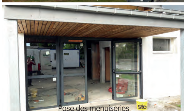
Isolation extérieure couverte par un bardage
